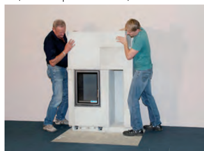
4. Jednotlivé díly na sebe skládat krok za krokem dle návodu a upevnit pomocí akrylového lepidla
