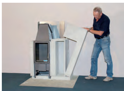
4. Jednotlivé díly na sebe skládat krok za krokem dle návodu a upevnit pomocí akrylového lepidla
