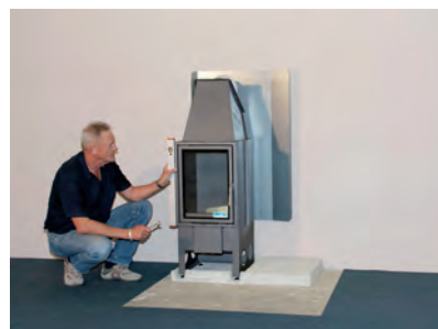
3. Ustavit krbovou vložku pomocí vodováhy
